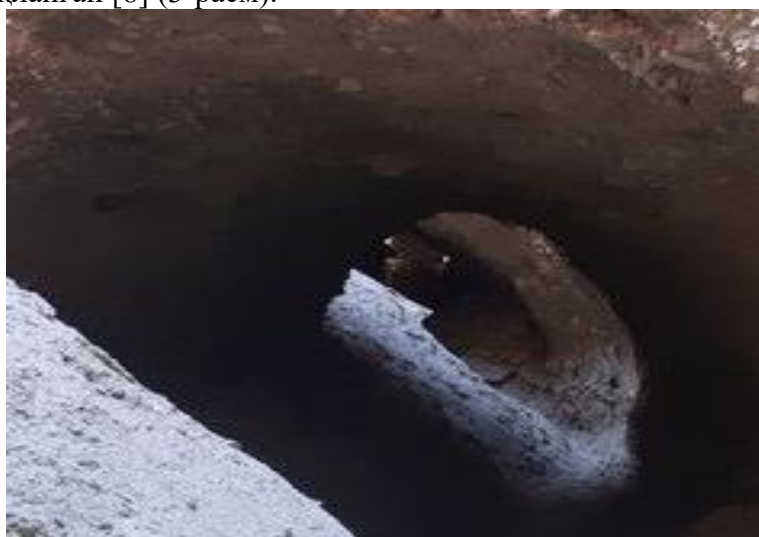
3-расм. Кориз ер ости сув иншоотининг туннель қисми (С. Суюнов бўйича -2015)
